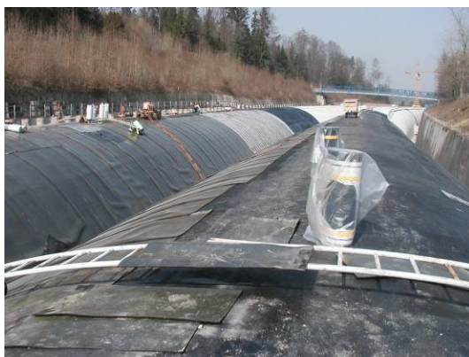
Tunnelröhren vor der Überschüttung (26.03.2003)
